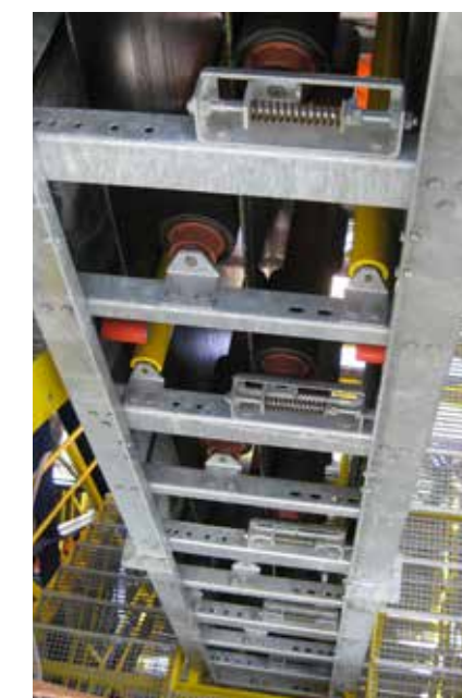
Shaft Construction Schachtkonstruktion
